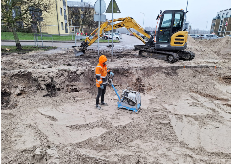
Gaujas ielas šķērsojuma caurtekas pārbūve.
