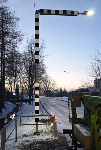
Apgaismotas gājēju pārejas izbūve.
